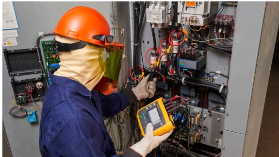
Utiliser un enregistreur évolué de qualité d'énergie Fluke 1738 pour effectuer une étude énergétique sur un système mécanique
